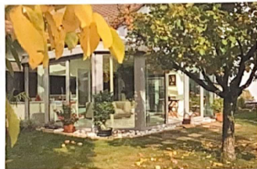
Wenig Neues für den Wintergartenbau: Auch mit dem seit 1. November 2020 gültigen GEG können Wintergärten in Wohnraumqualität gebaut werden. Foto: Bundesverband Wintergarten e.V.
