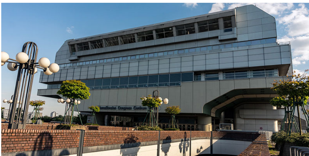
Auffälligstes Merkmal des Internationalen Congress Centrum Berlin: die silbergraue Aluminium-Fassade im High-Tech-Architekturstil (Quelle: Axel Scholty/Pixabay)
